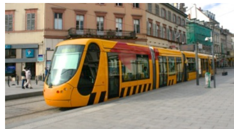
Le tram moderne de Mulhouse avec son quai trottoir invisible parfaitement intégré au mobilier urbain.
